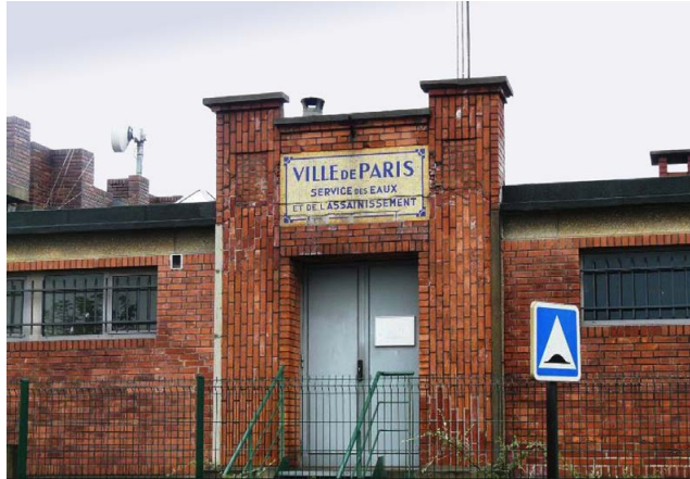
Entrée du réservoir de l'Avre à Saint-Cloud.
