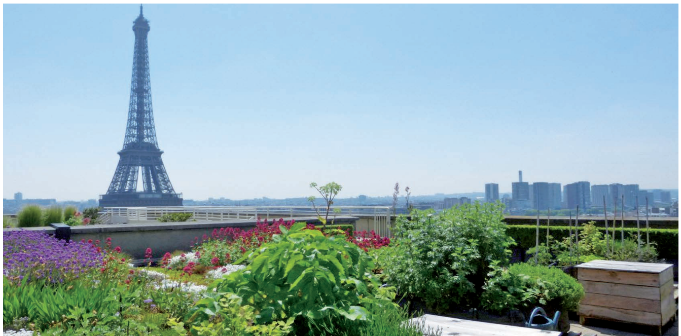
La végétalisation des toitures, comme ici sur la Cité de l'architecture et du patrimoine à Paris, permet que l'eau de pluie soit absorbée là où elle tombe.
