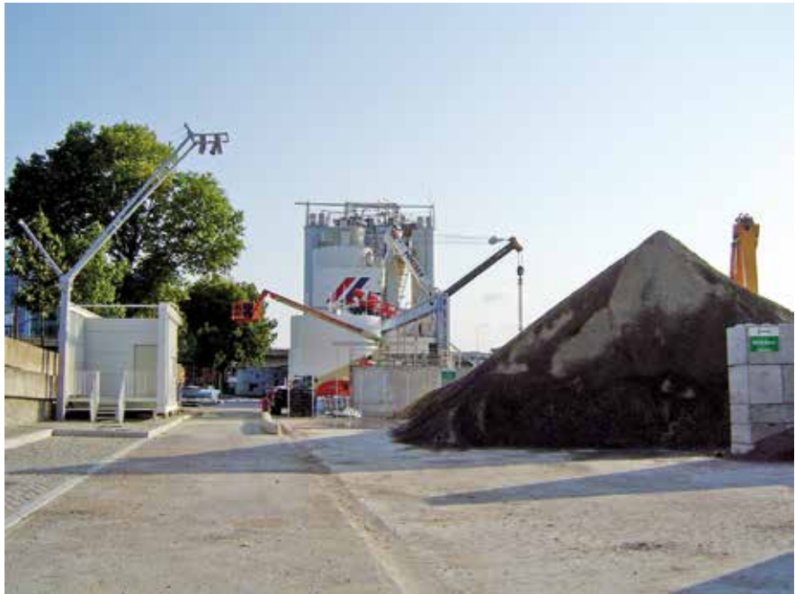
Port Victor entre périphérique et Pont du Garigliano, en cours de réhabilitation pour des usages partagés.
